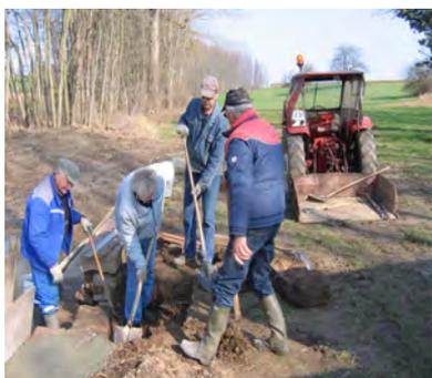
Les 30 et 31 mars, coffrage du pan de mur le plus délabré afin de le stabiliser par du béton.
